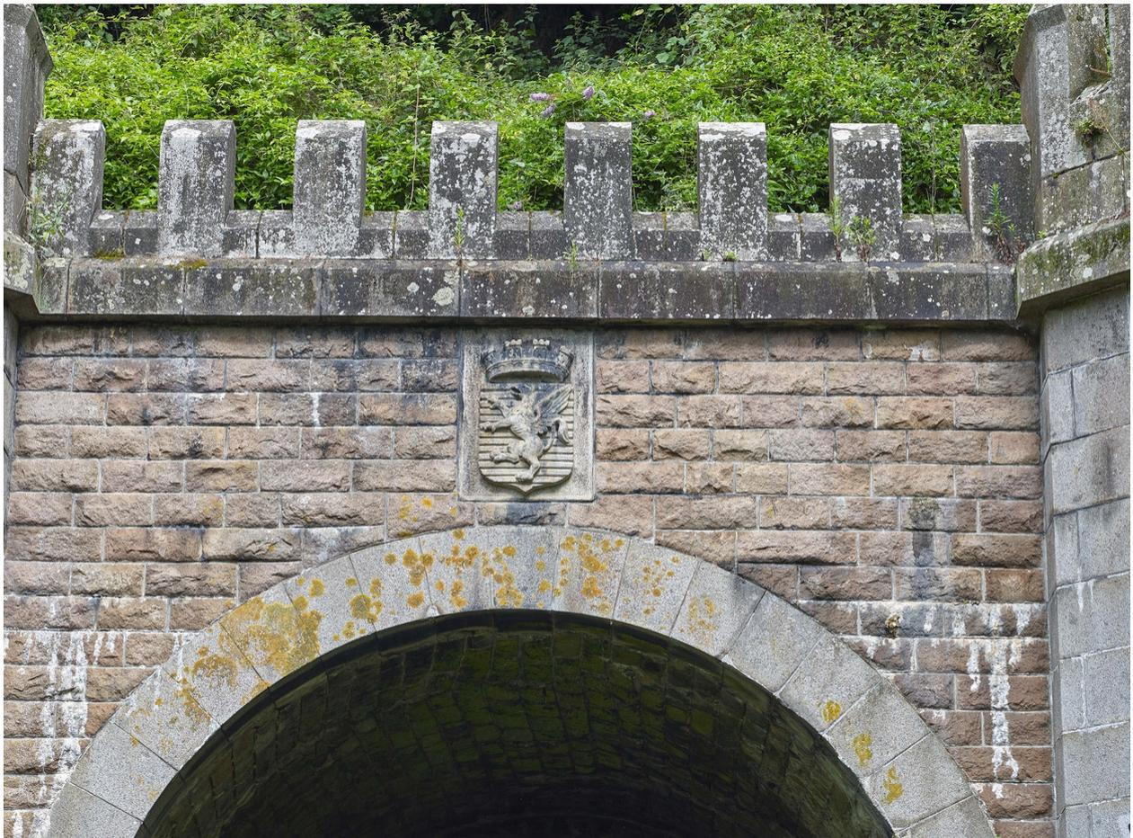
Vue de l'entrée côté Port du Légué dans le style néo-gothique : partie centrale crénelée en appareillage de moellon équarri de granite rose à la face brute. Crénelage, tablette et arc de voûte en anse de panier sont en granite gris. Au centre, les armoiries de la Ville de Saint-Brieuc
