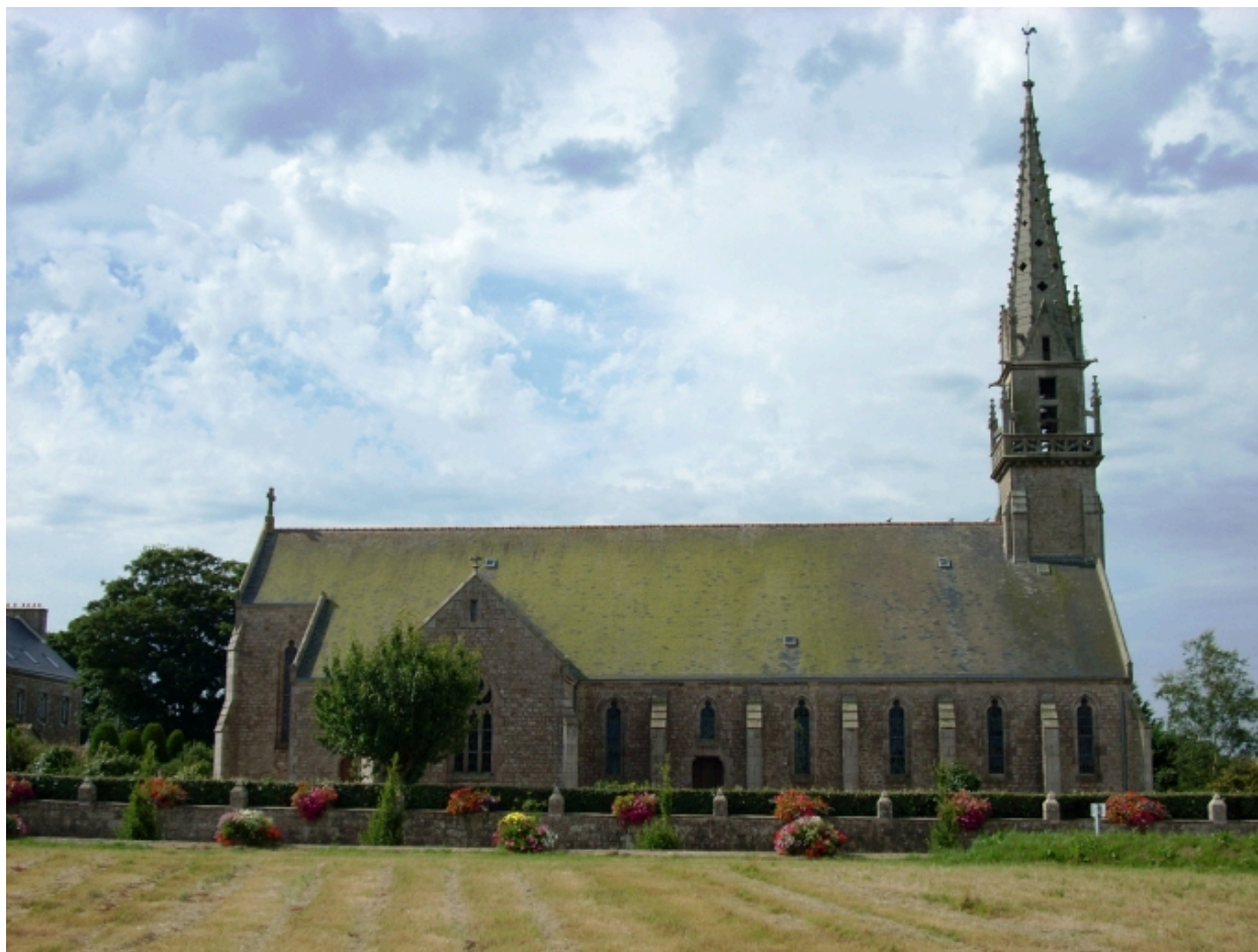
Vue générale, élévation nord
