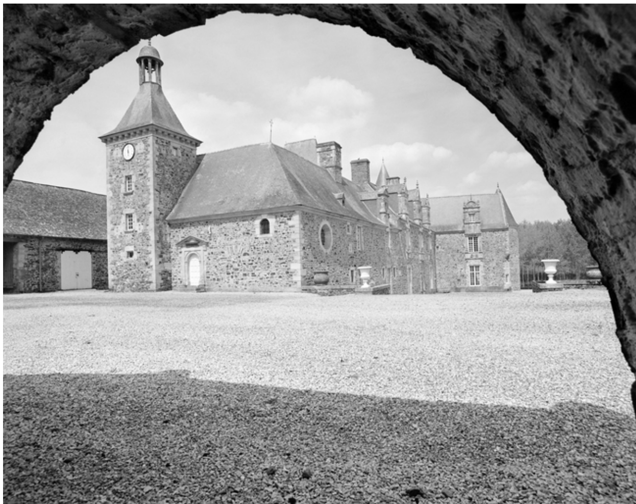
Chapelle : vue générale sud-est.
