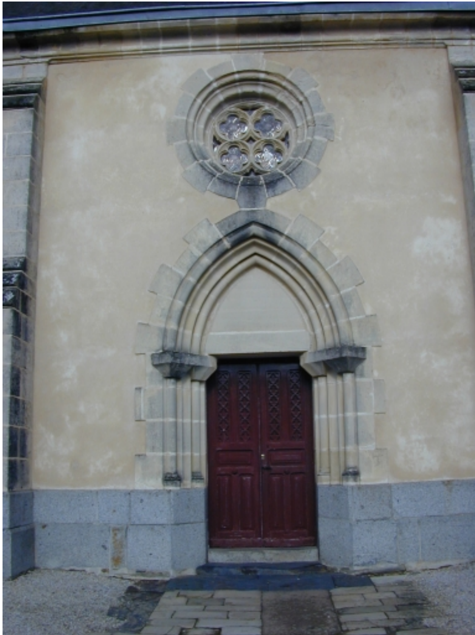
La porte latérale : vue générale sud
