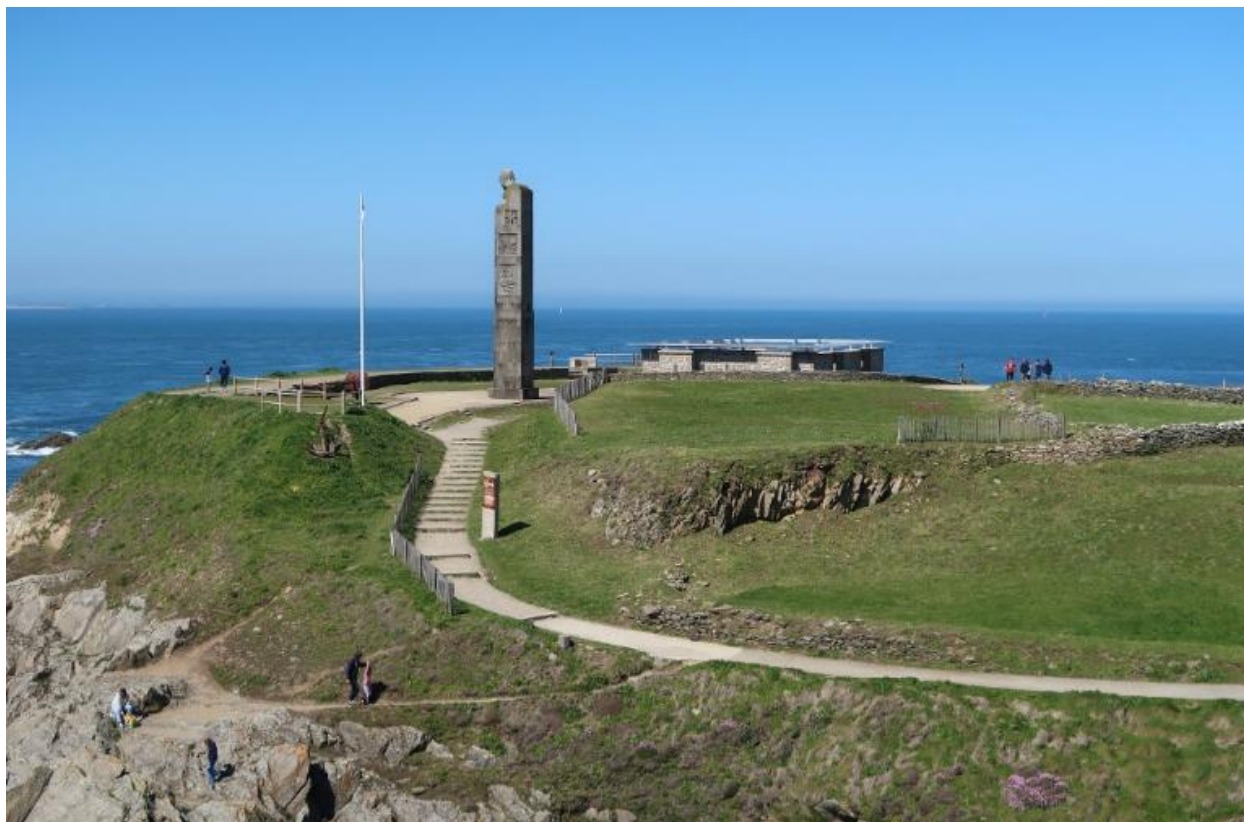
Vue de situation depuis le sud-sud-est
