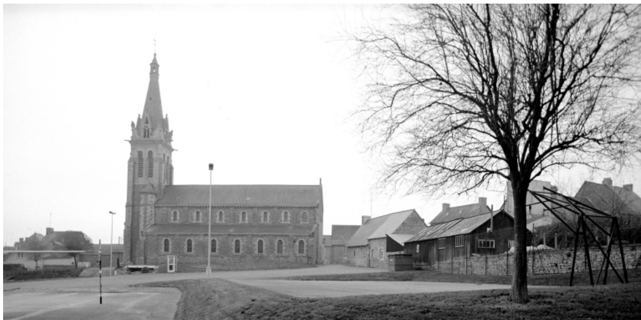
Elévation Sud : vue générale
