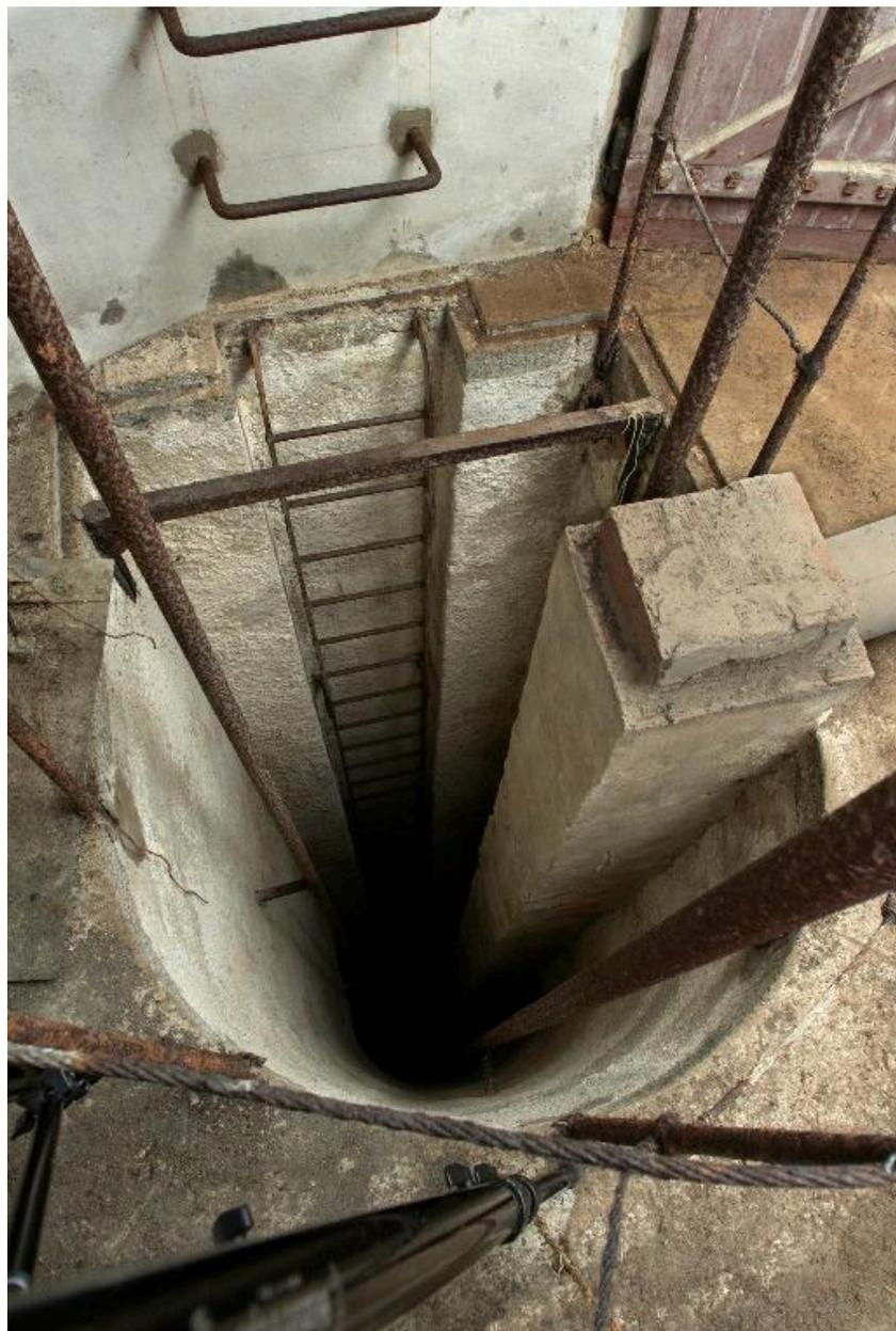
Vue du puits du monte-charge du magasin à poudre sous roc. Il est doublé d'une échelle
