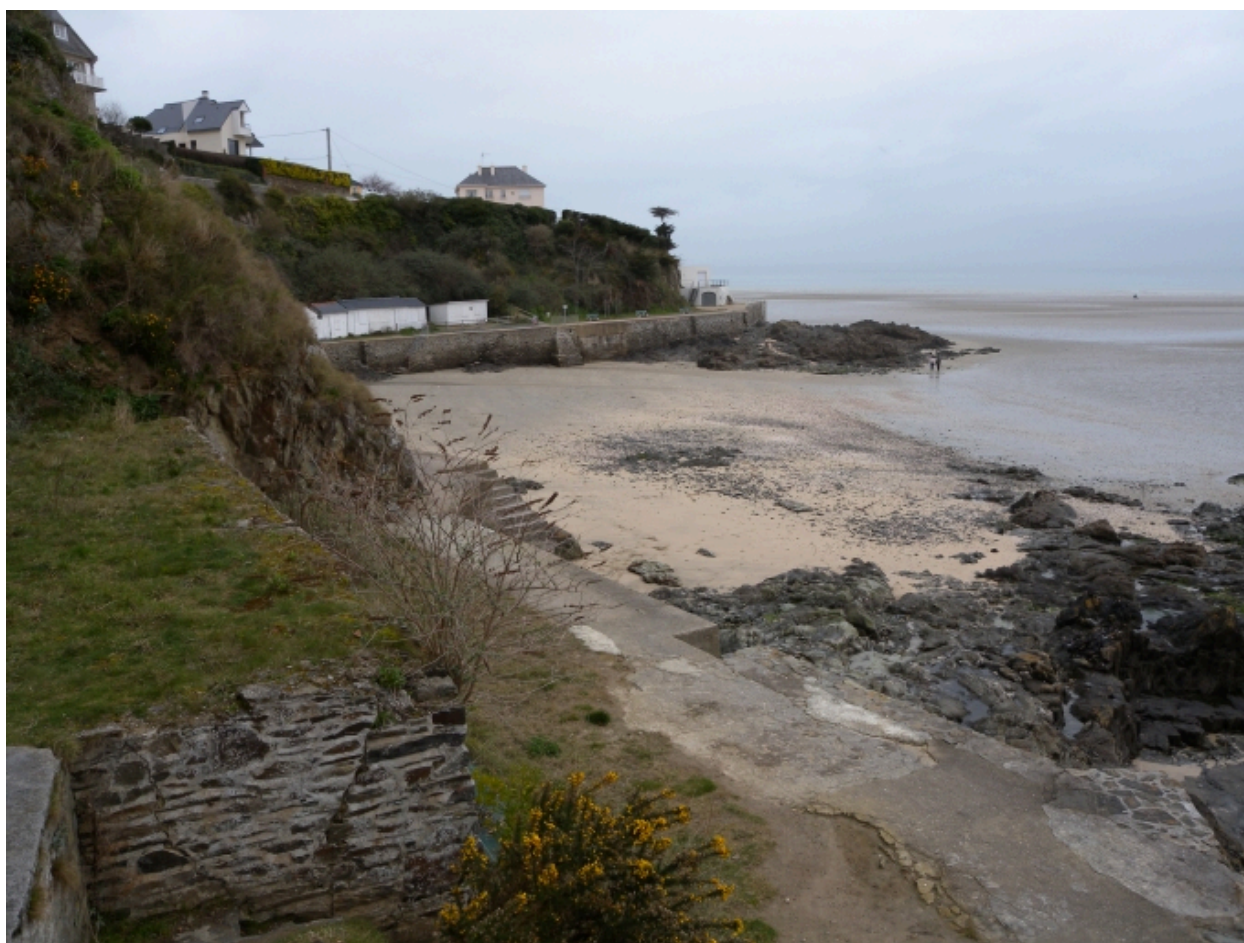
Vue de la digue-promenade Est
