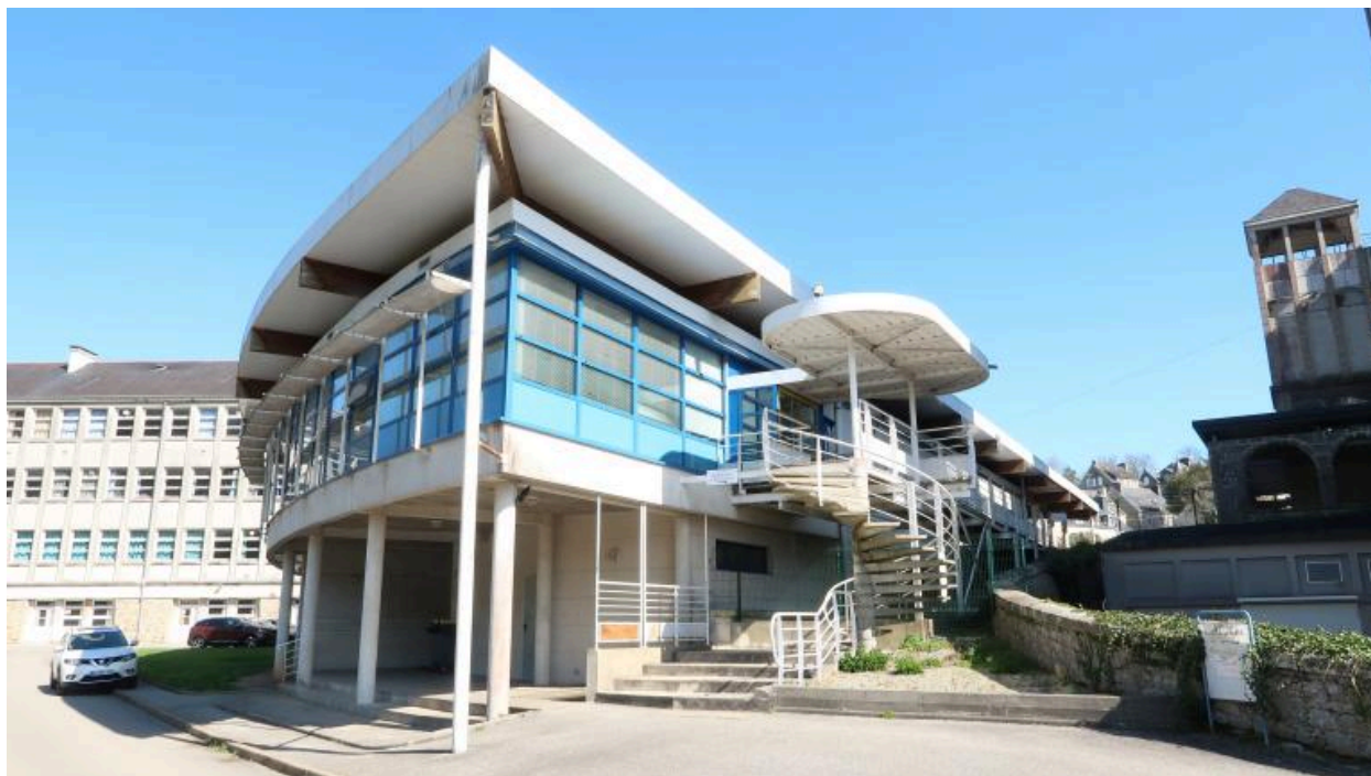
Angle sud-ouest du bâtiment des formations hôtelières, atelier Duhamel, architectes, 1994.
