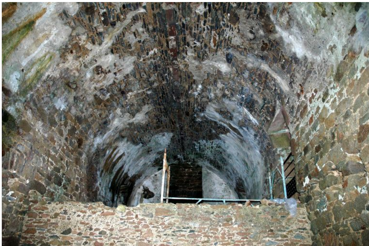
Vue de la redoute, réduit de l'île aux Moines : voûte du casernement
