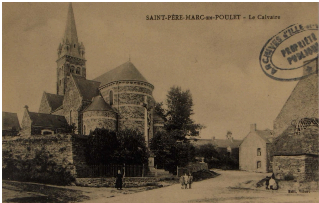
Vue de 3/4 du chevet et de l'élévation ouest
