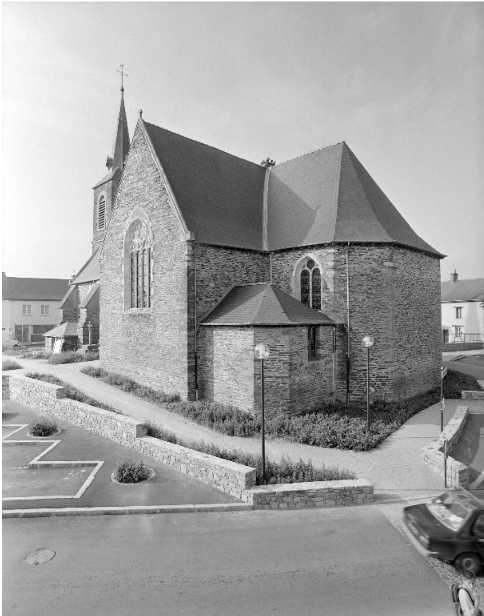
Elévation Sud-Est : vue générale (Etat en 1994)
