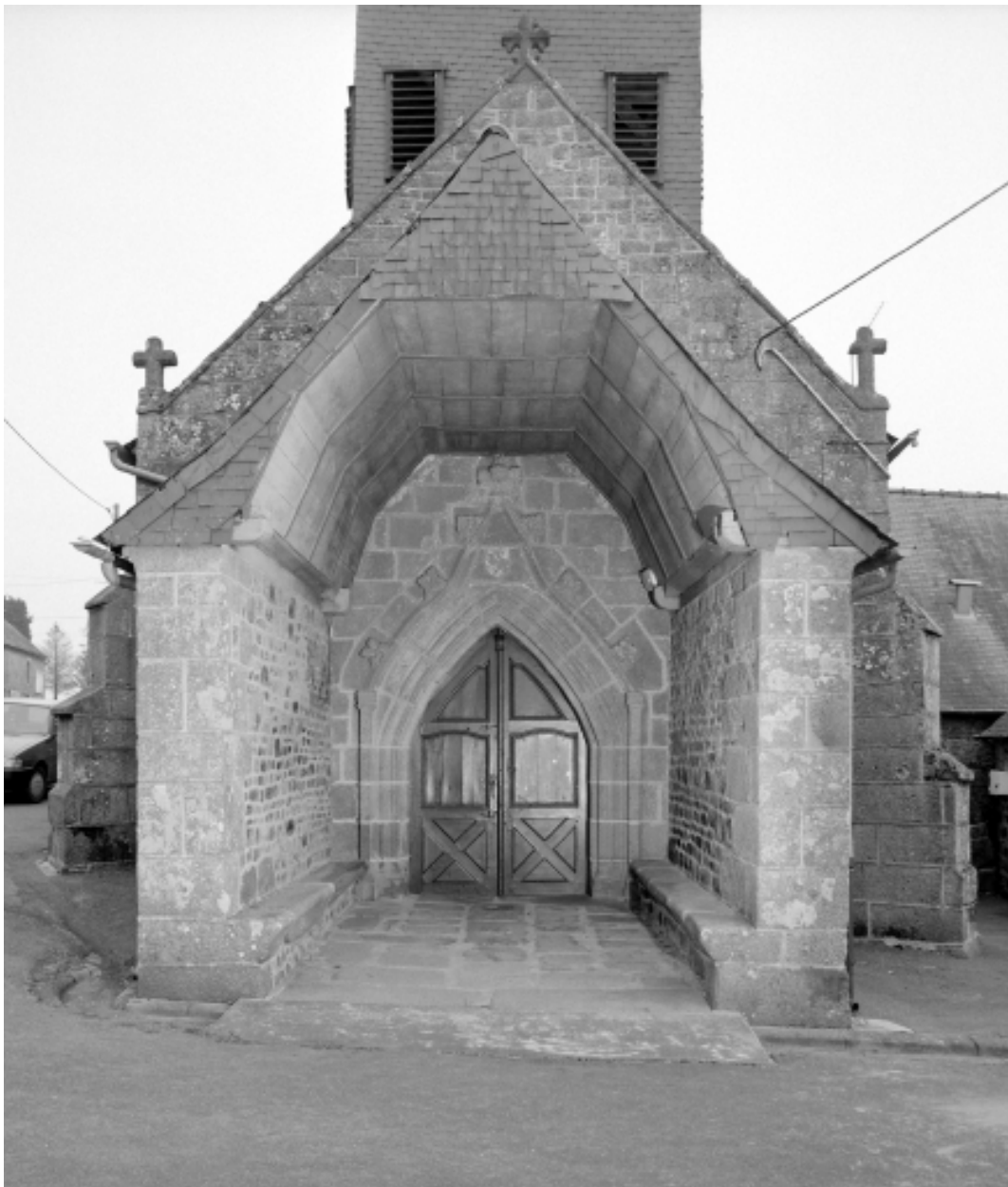
Elévation Ouest, porte principale : vue générale
