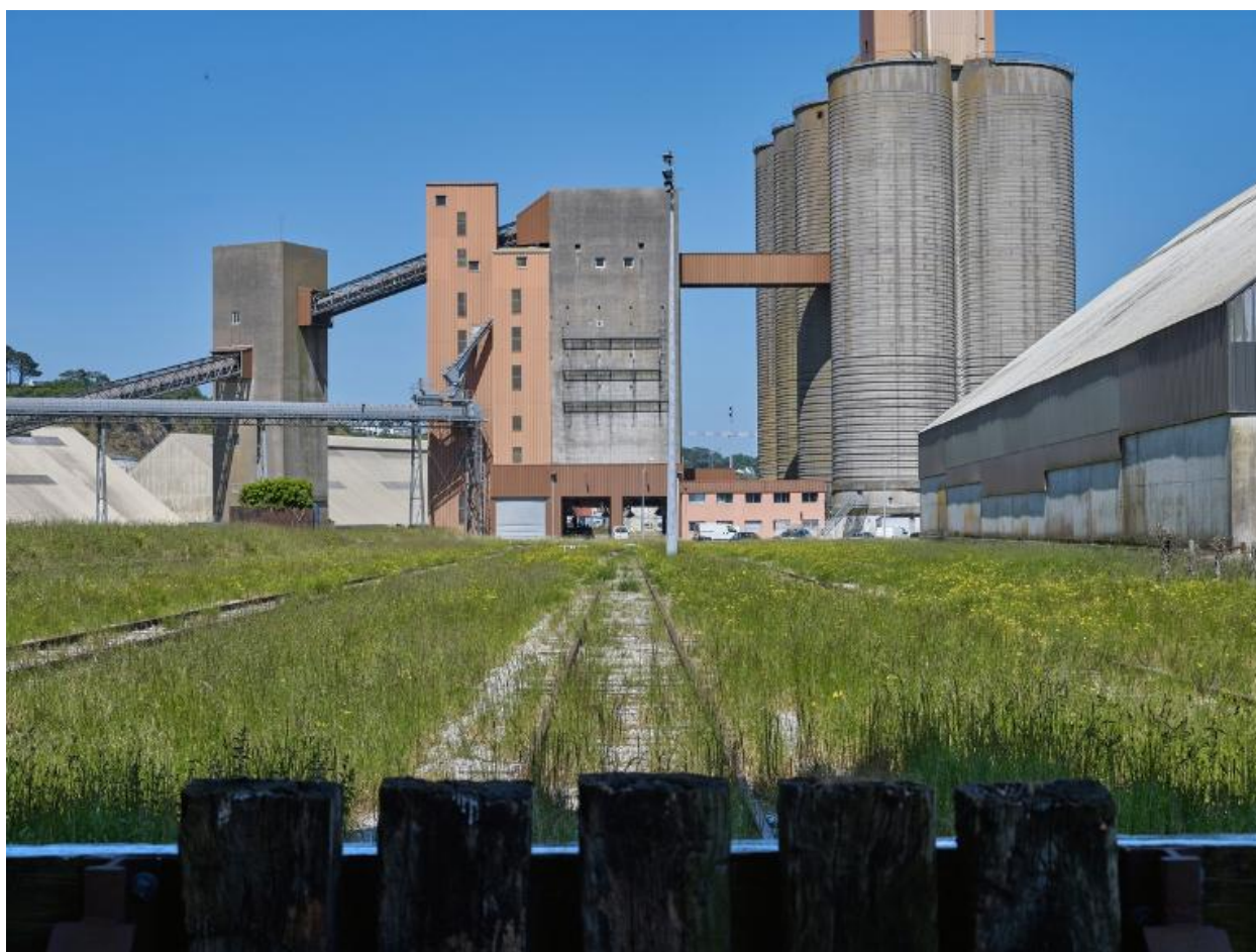
Silos portuaires, tour de liaison, bandes transporteuses et voies ferrées
