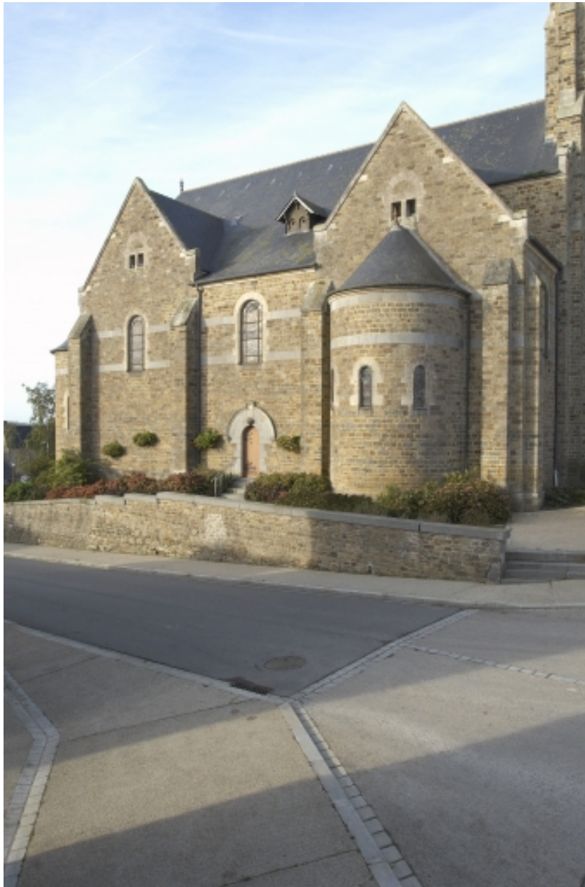
Vue générale de l'élévation est
