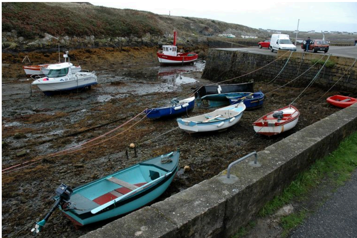
Vue du port-abri de Lampaul
