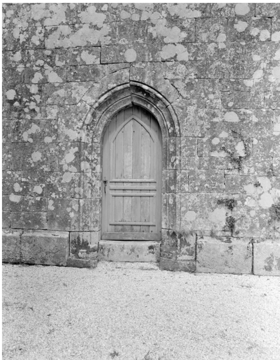
Bras sud, mur ouest : détail de la porte
