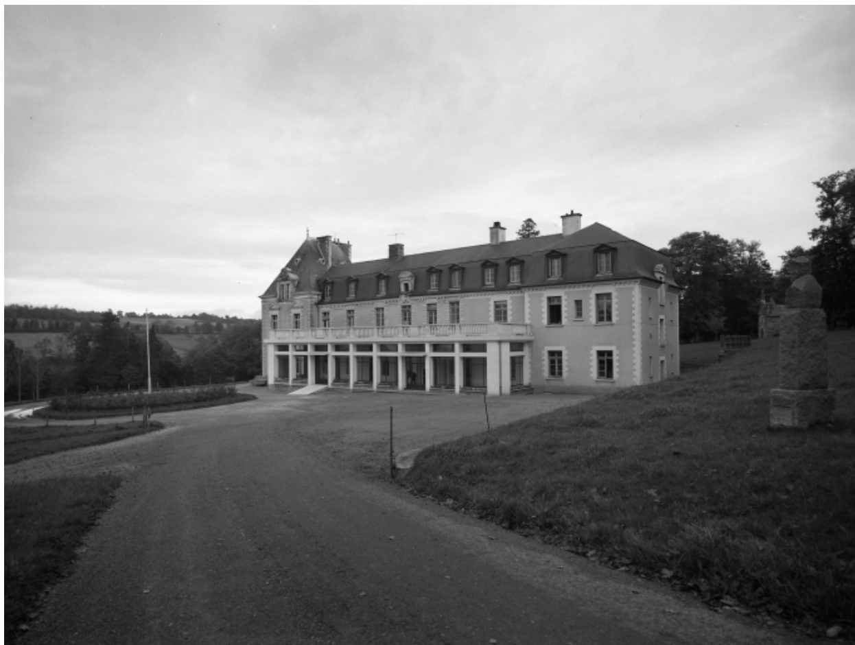
Elévation ouest, vue générale.
