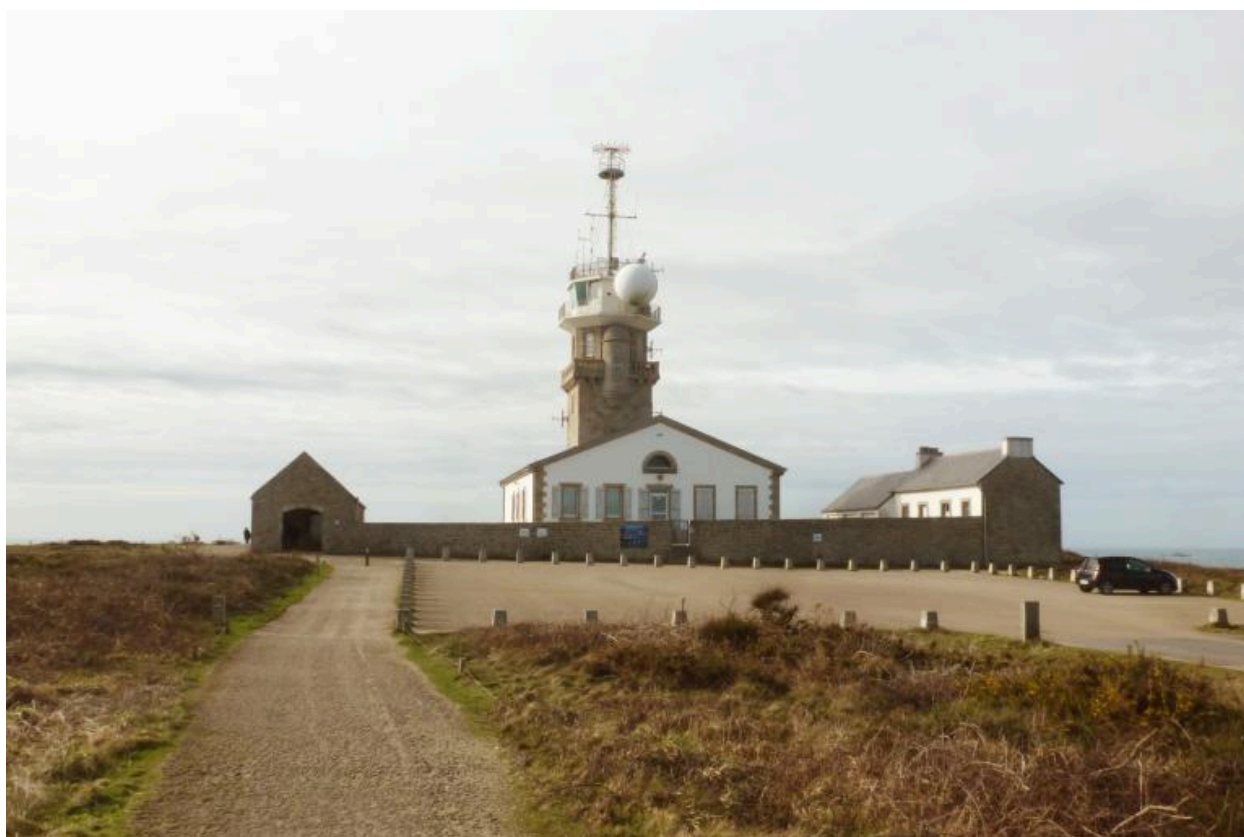
Vue générale prise de l'est. (2019)
