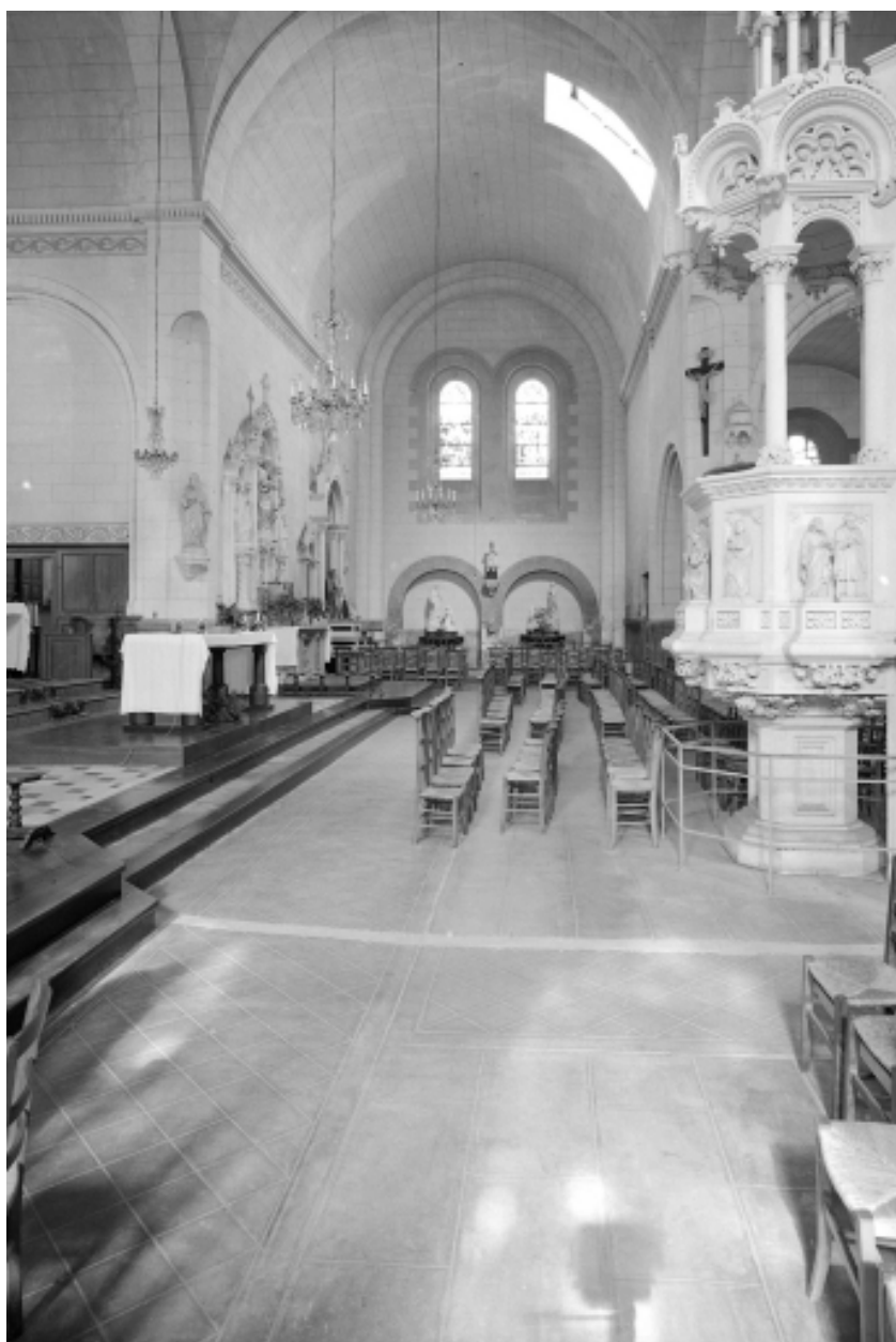
Intérieur, bras Nord du transept : vue générale.
