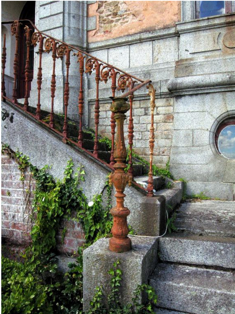
Détail du perron et escalier extérieur
