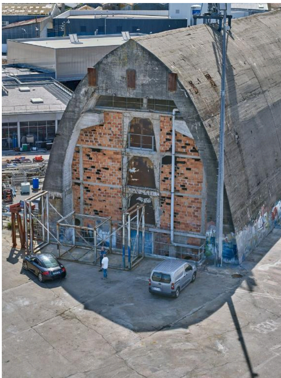
Vue générale depuis le nord : pignon percé de quatre portes
