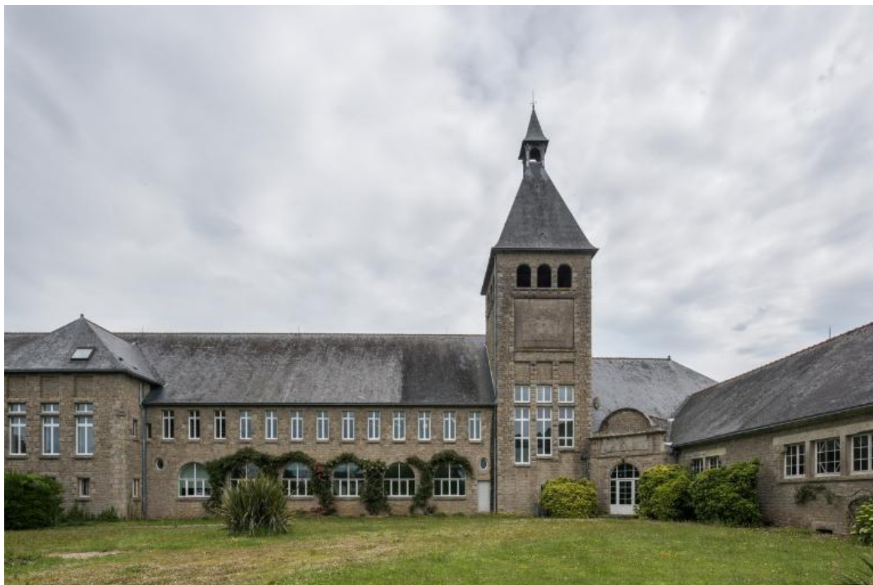
Vue d'ensemble prise de l'ouest. Façade ouest de l'aile nord, campanile et façade nord de l'aile ouest. Georges-Robert Lefort, architecte, 1929.
