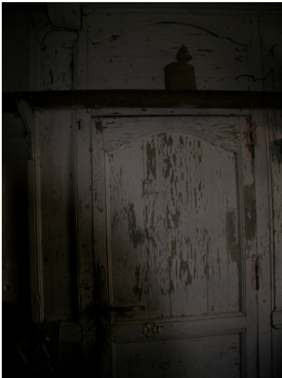
Porte du rez-de-chaussée
