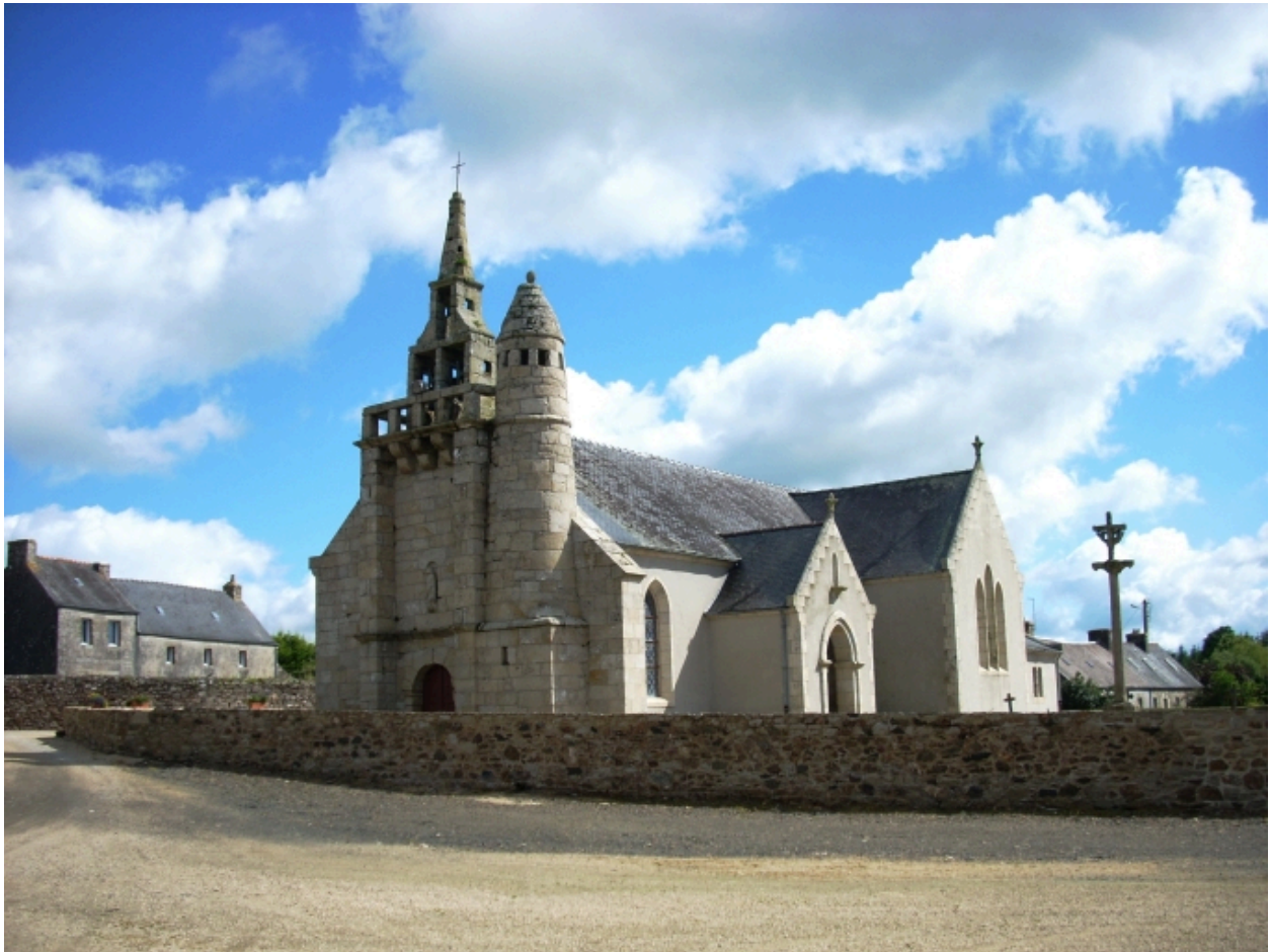
Bolazec, église paroissiale Notre-Dame et Saint-Guénaël : vue générale sud-ouest
