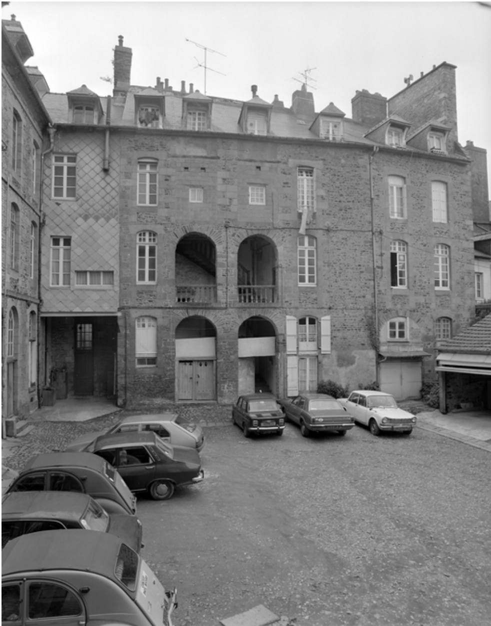
Elévation postérieure, corps latéral, vue générale.
