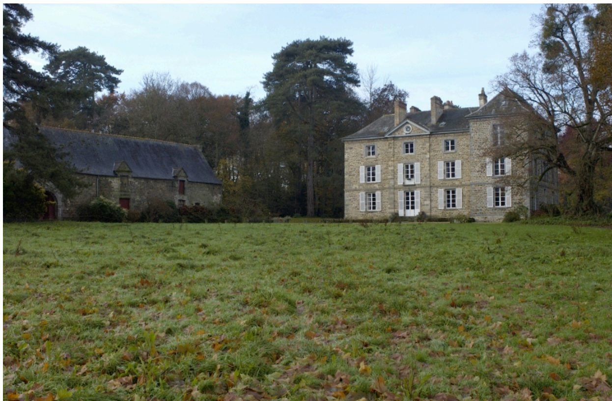
Vue de situation sud-est
