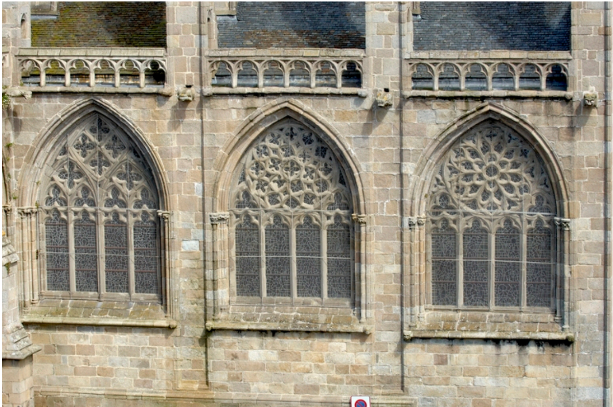
Détail des fenestrages du chevet
