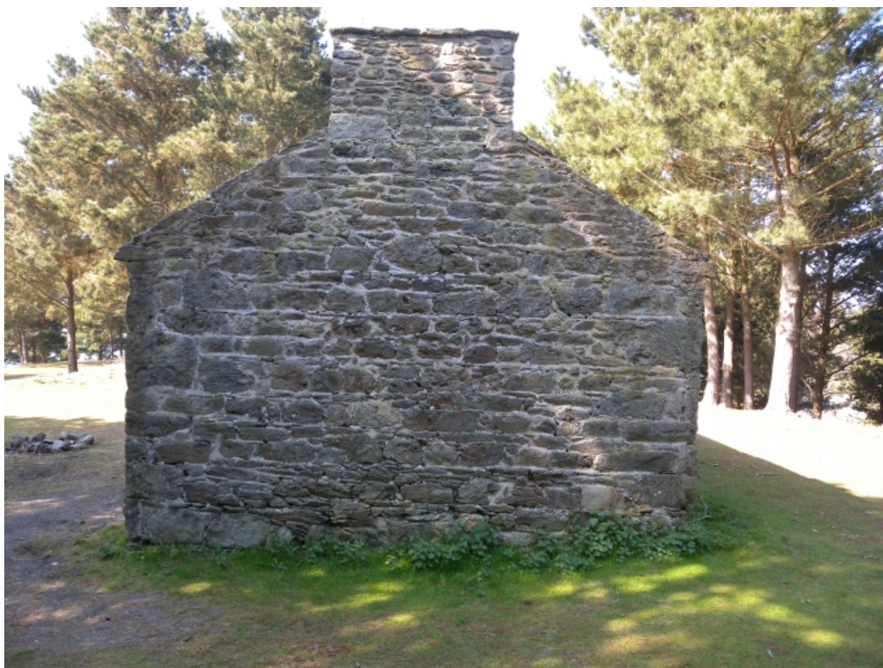
Vue du pignon aveugle
