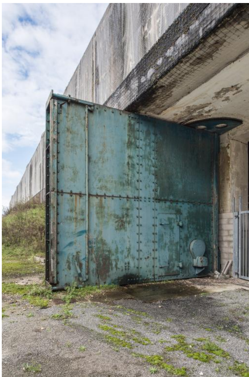
Vue de la porte blindée sud. La porte est dotée d'une petite avancée de protection
