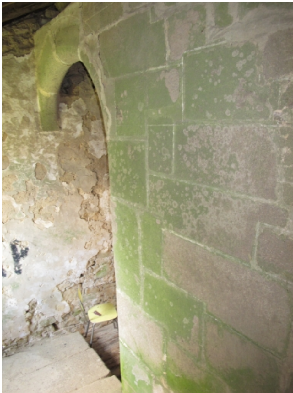
Palier de l'escalier
