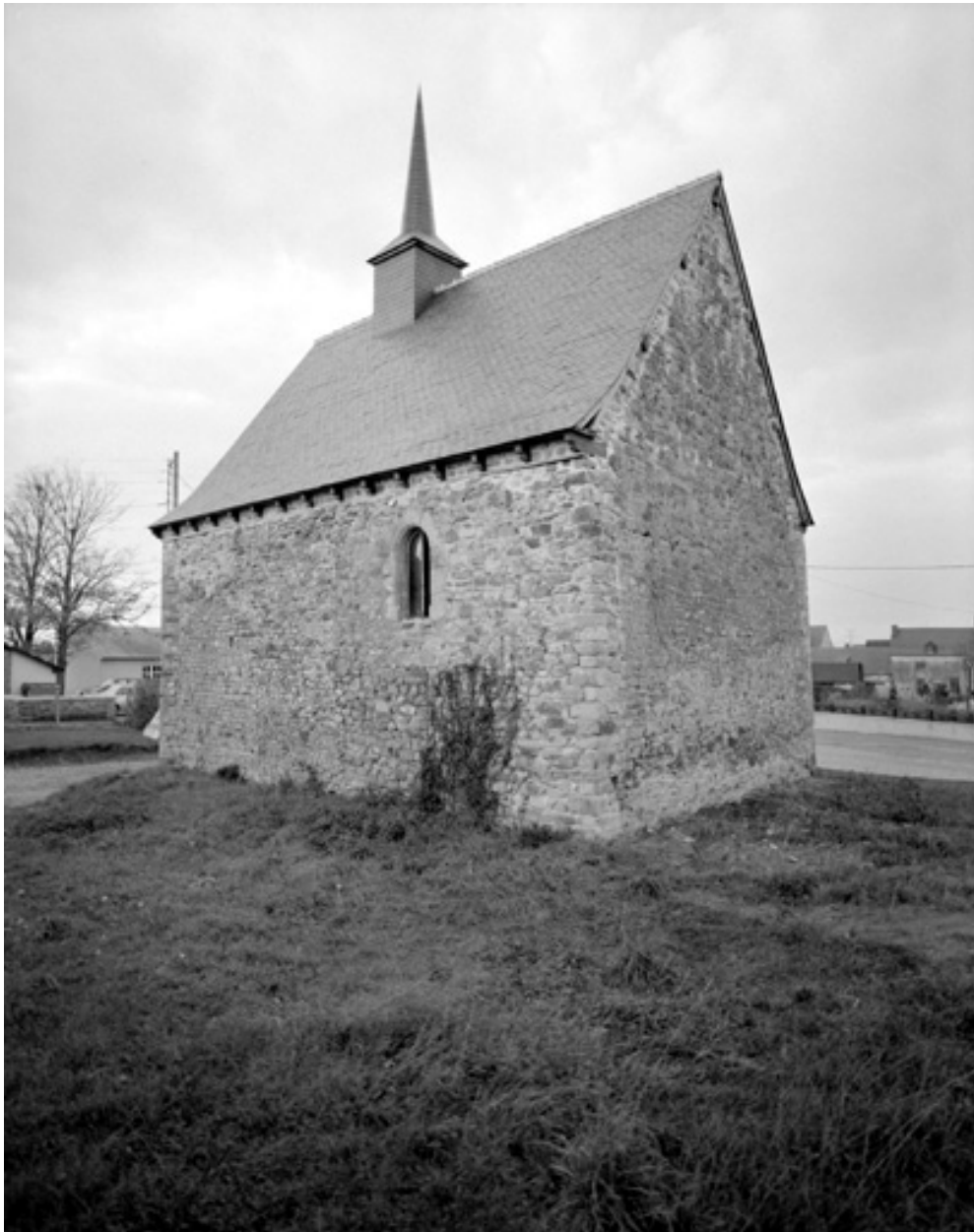
Vue générale de la chapelle
