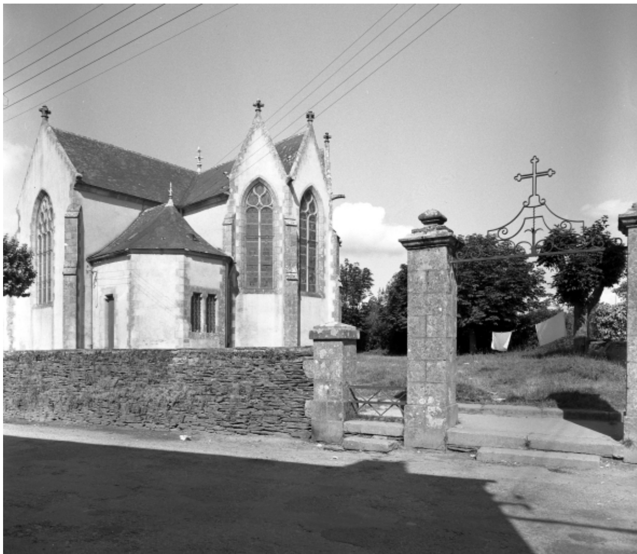
Saint-Goazec, église paroissiale Saint-Pierre : vue générale sud-est, état en 1966
