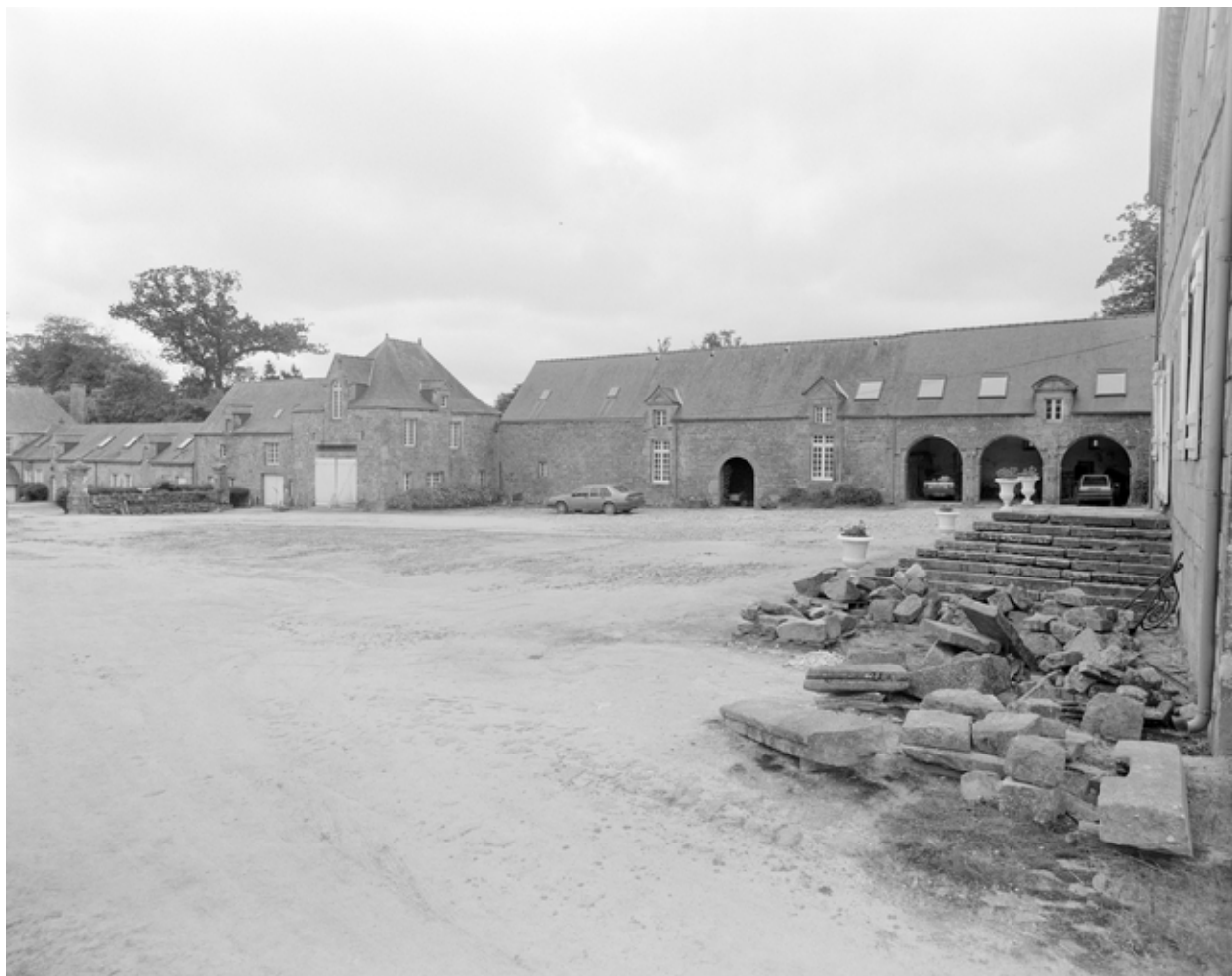
Vue générale de la cour du château, flanc ouest, état en 2000.
