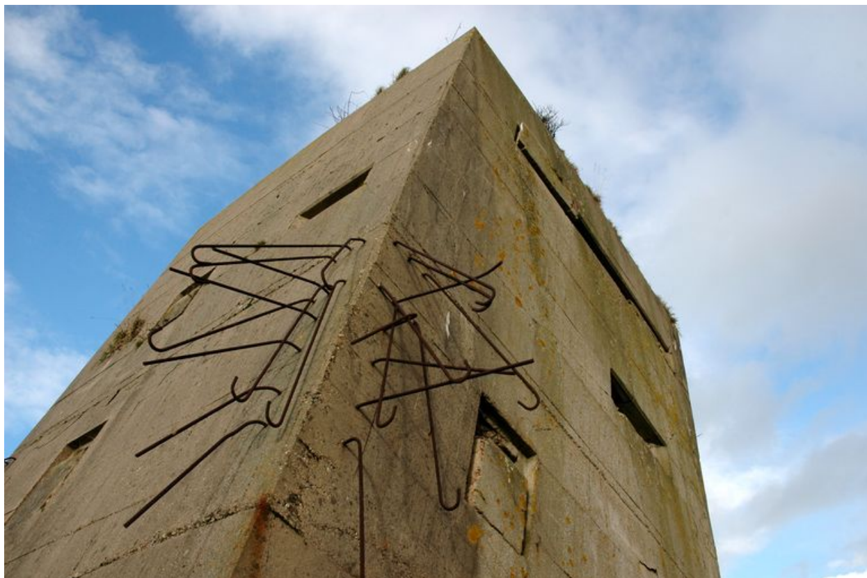
Pas-de-Calais : vue du poste de direction de tir de la batterie des Huttes d'Oye
