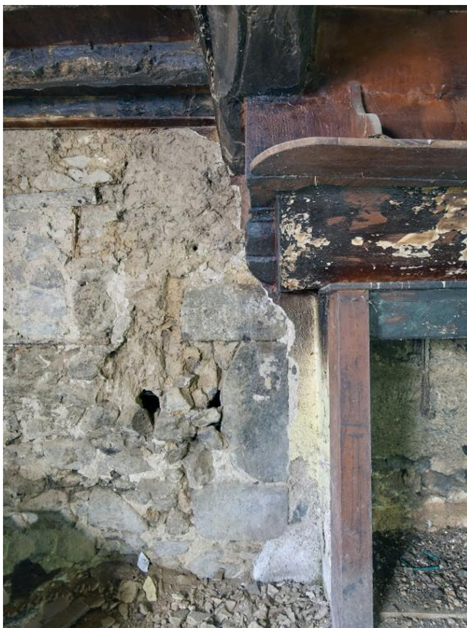
Logis sud. Pignon sud. Cheminée ancienne en pierre derrière l'habillage moderne en bois
