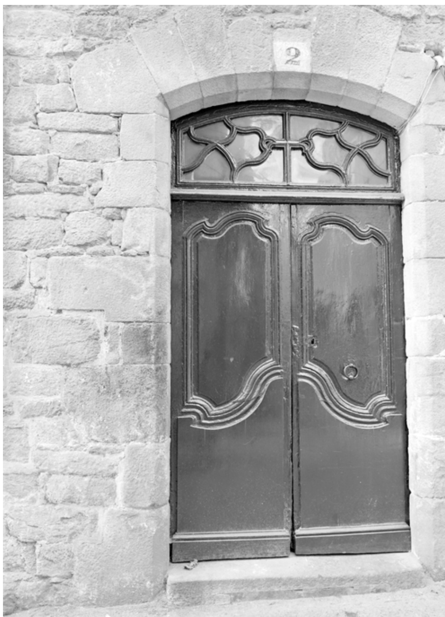
Porte chanfreinée au linteau en arc surbaissé.
