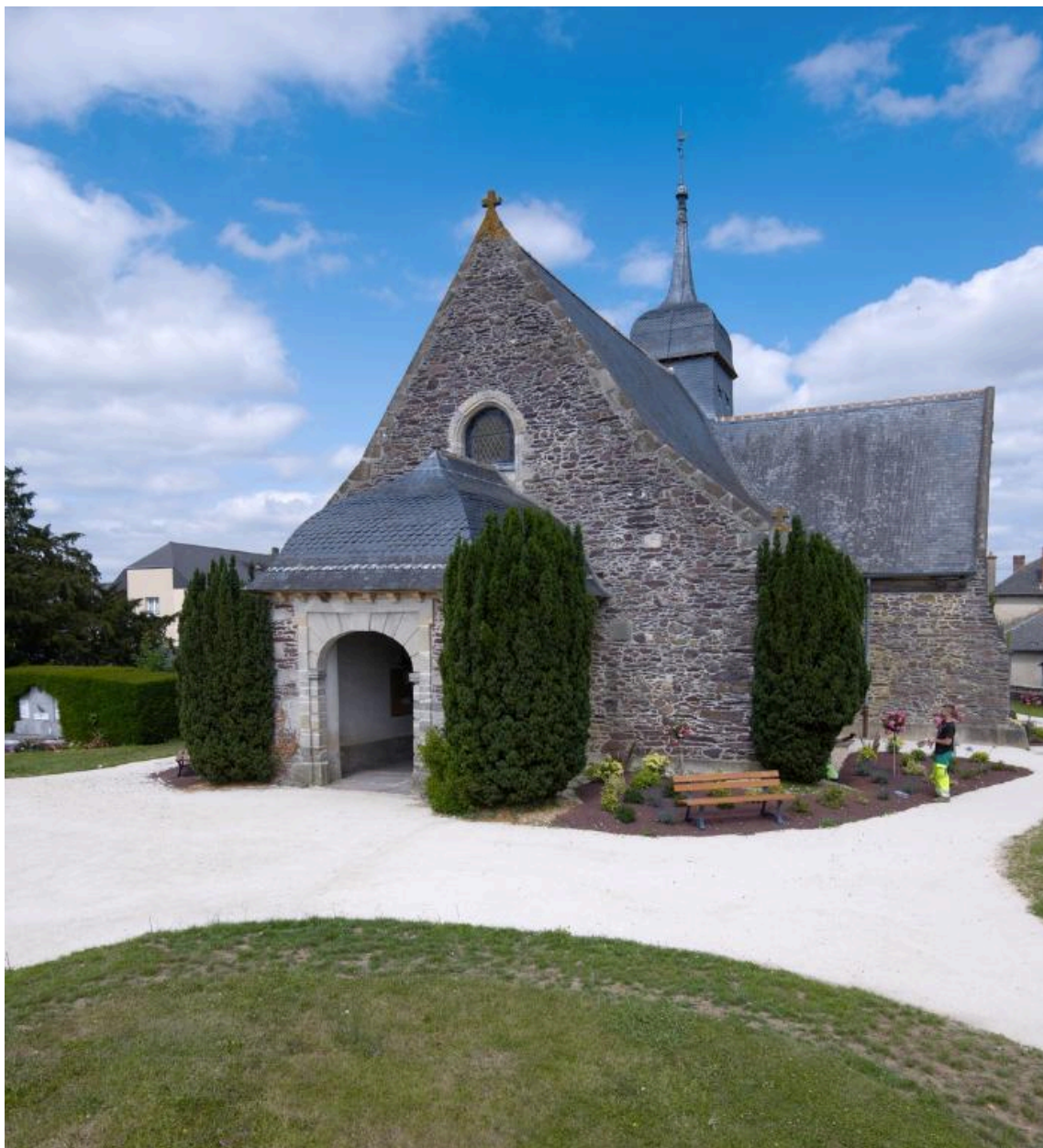
Vue ouest de l'église
