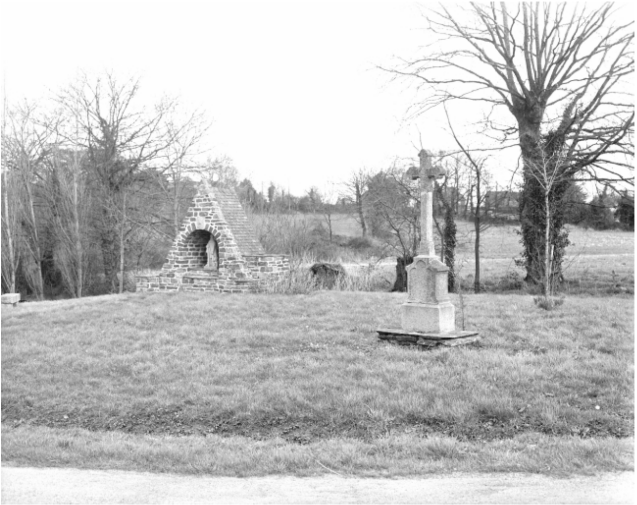
Site de l'Ormeau, croix monumentale et oratoire : vue de situation
