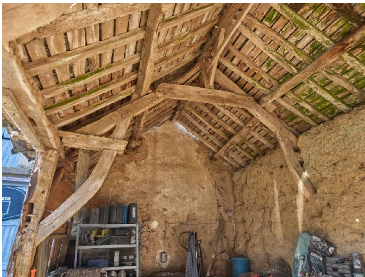
Remise. Charpente à sous-faîtage et jambes de force courbes
