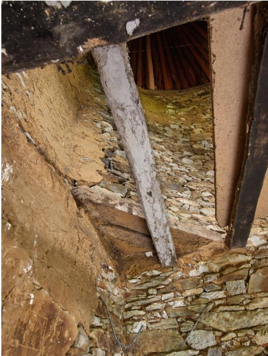
Vue à travers le plafond du rez-de-chaussée montrant le passage du plan carré au plan octogonal.
