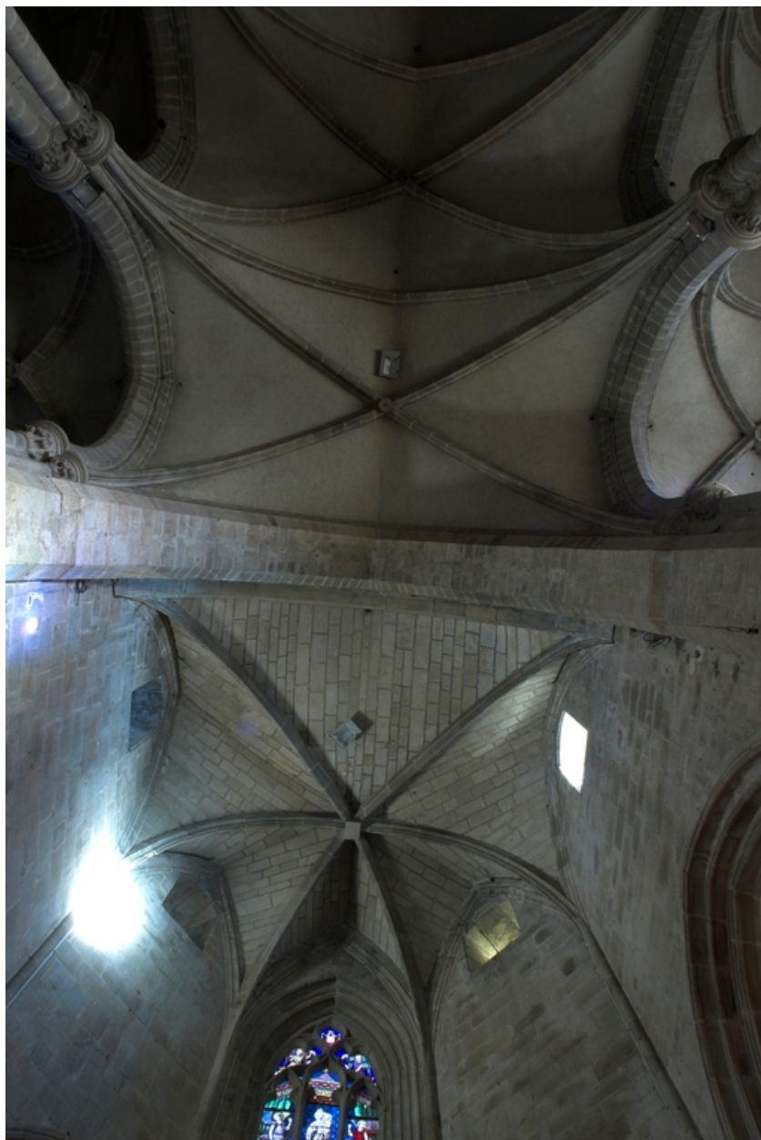
Choeur, vue des voûtes de l'abside
