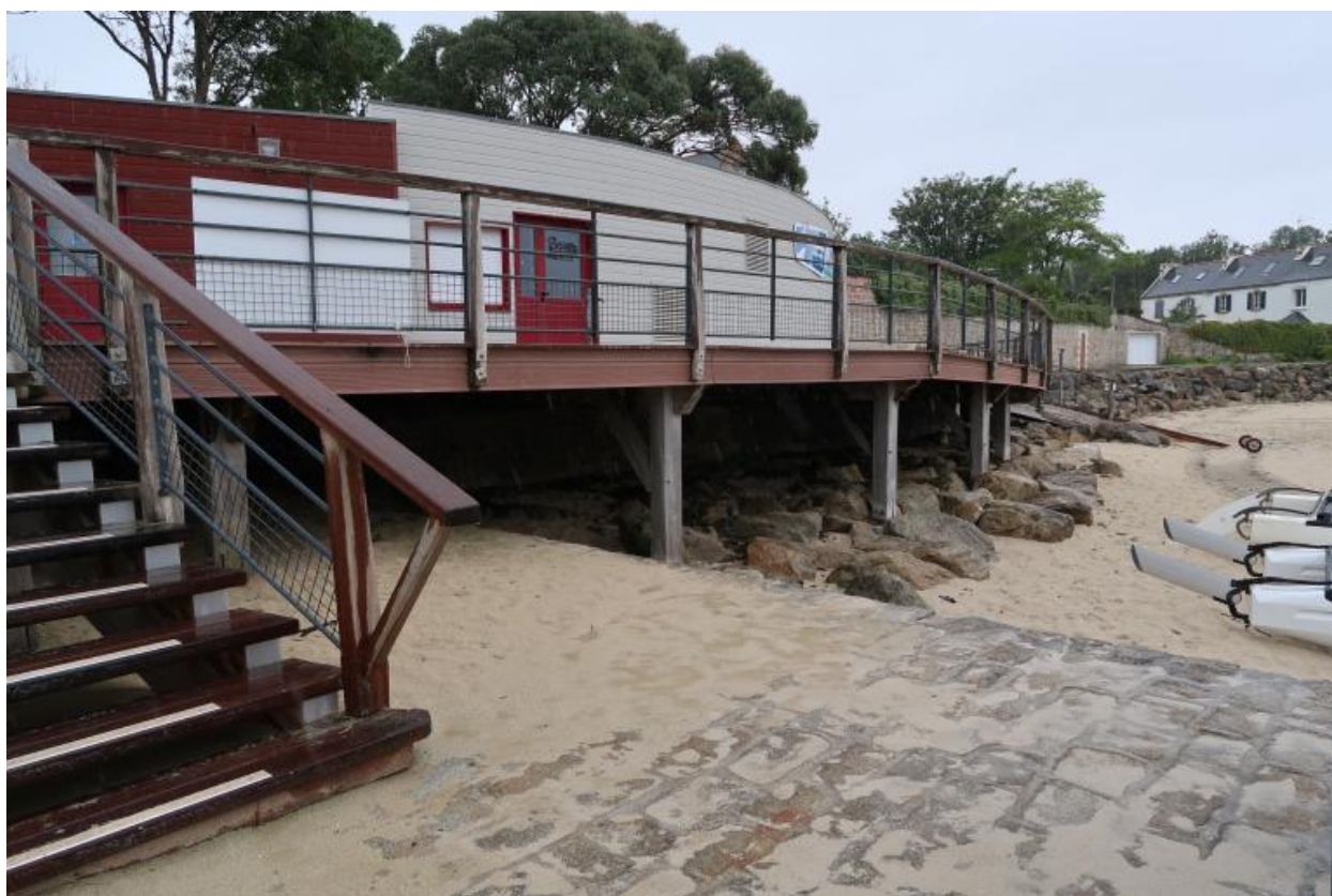
Enrochements sous le club nautique
