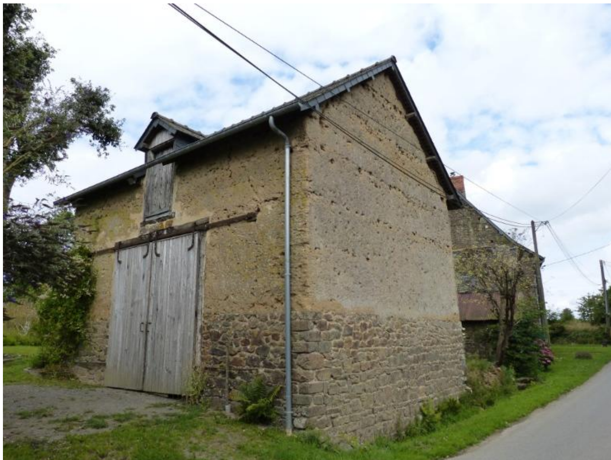
Grange vue générale sud ouest
