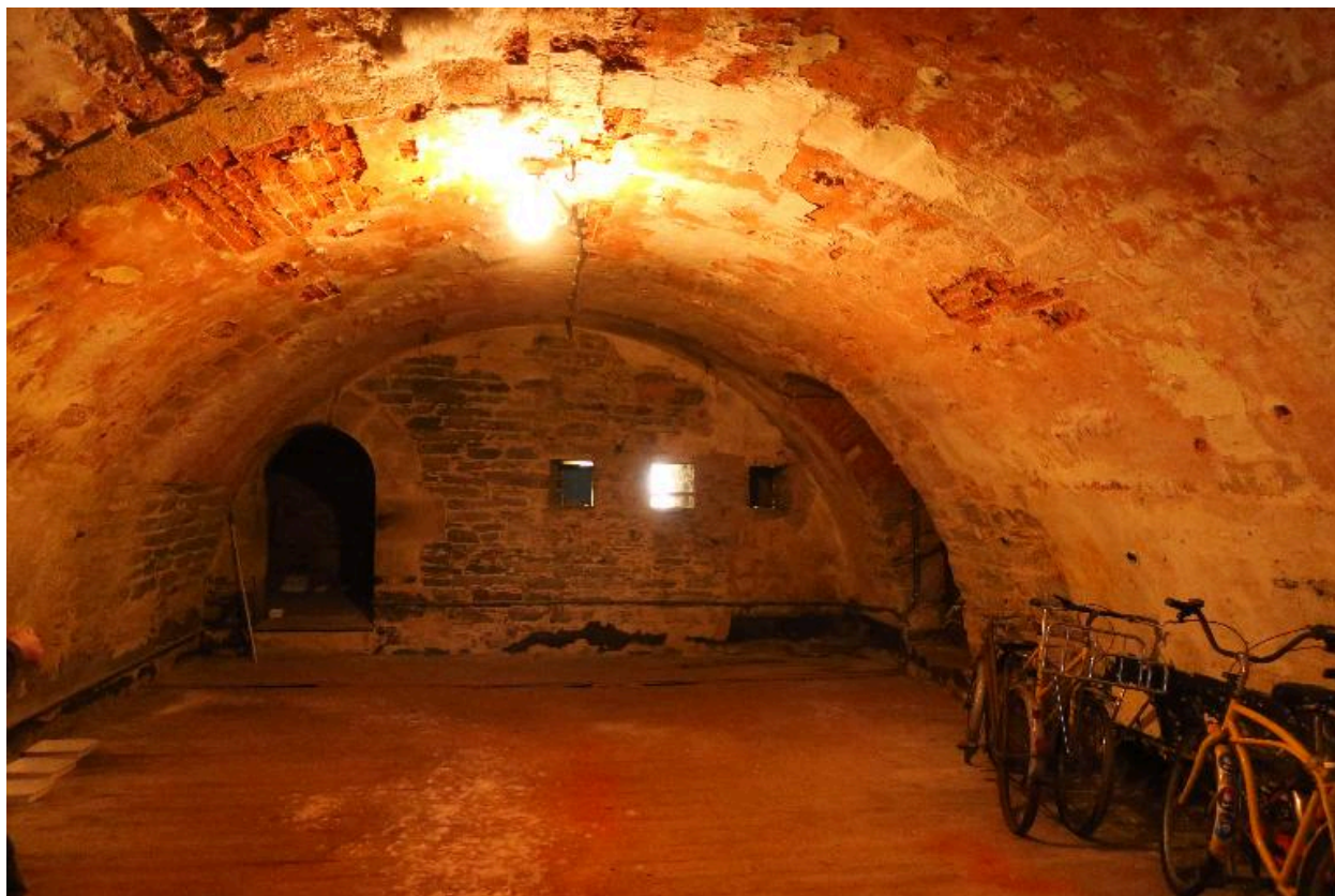
Le Palais, enceinte urbaine, réduit A, étage, première chambrée de gauche.
