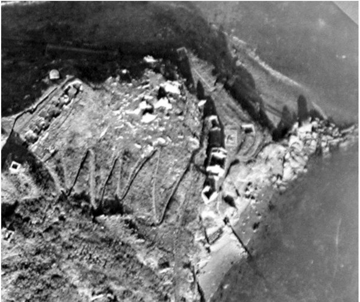
Vue aérienne (détail) de l'ensemble fortifié de la pointe des Espagnols, n° 132, rapport Pinczon du Sel. Livre IV, vers 1947, Service Historique de la Marine, Brest
