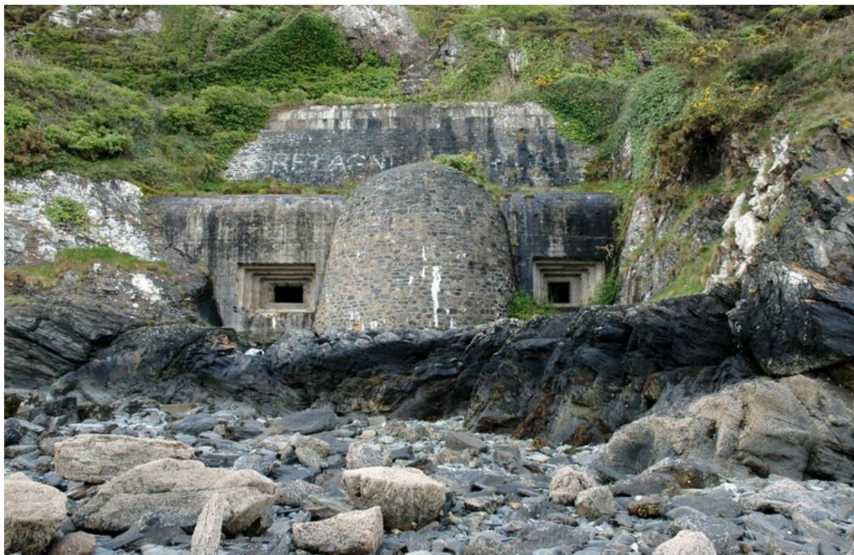
Vue des deux casemates en béton armé (état en 2006). Au centre, le massif en maçonnerie de la batterie casematée
