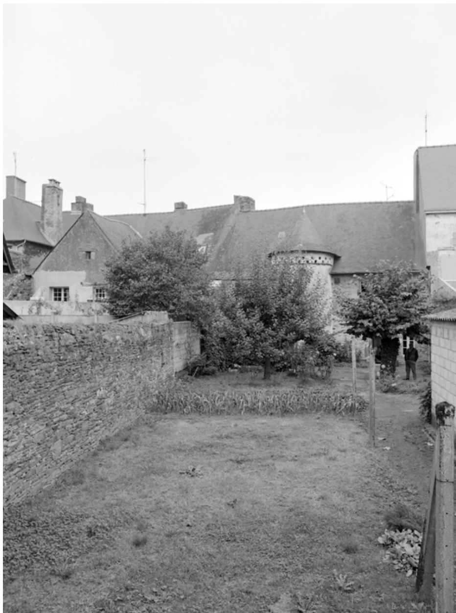
Maison : élévation postérieure (état en 1984)
