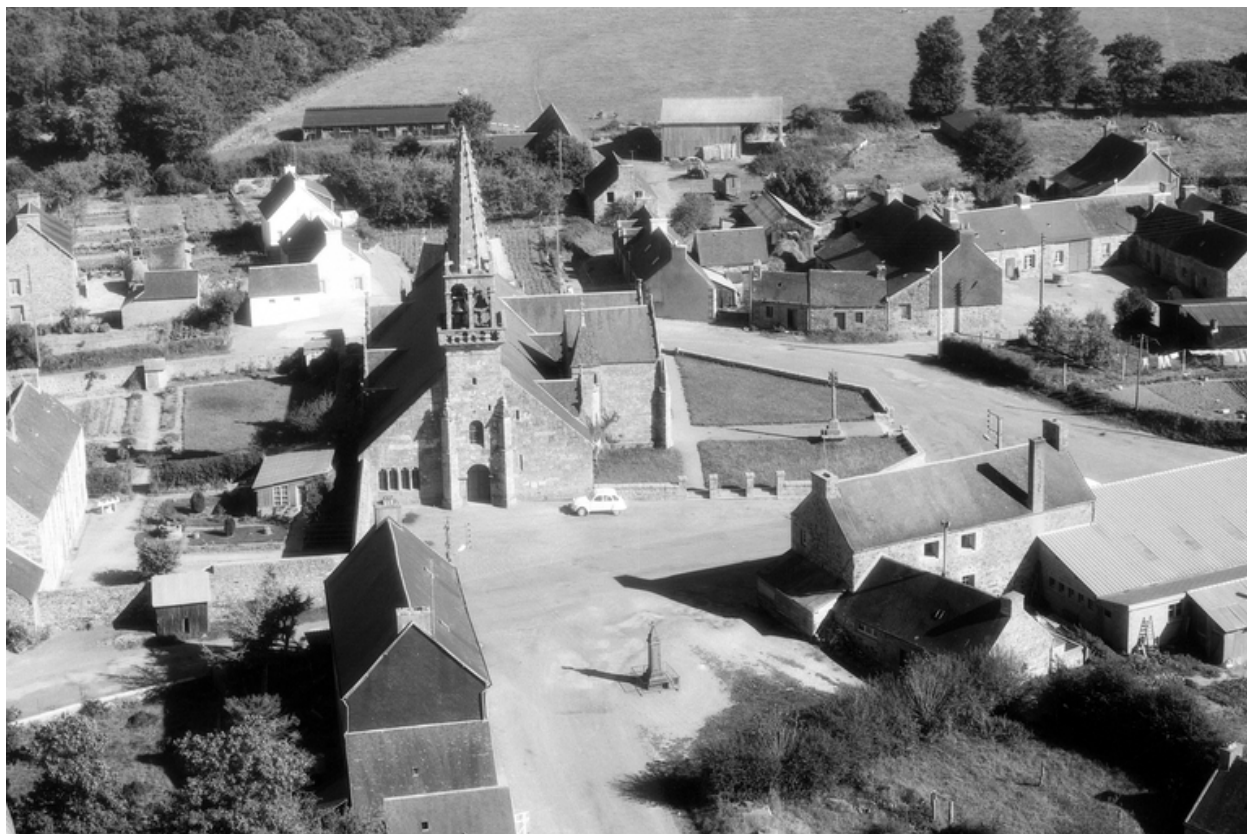
Vue de situation prise de l'ouest
