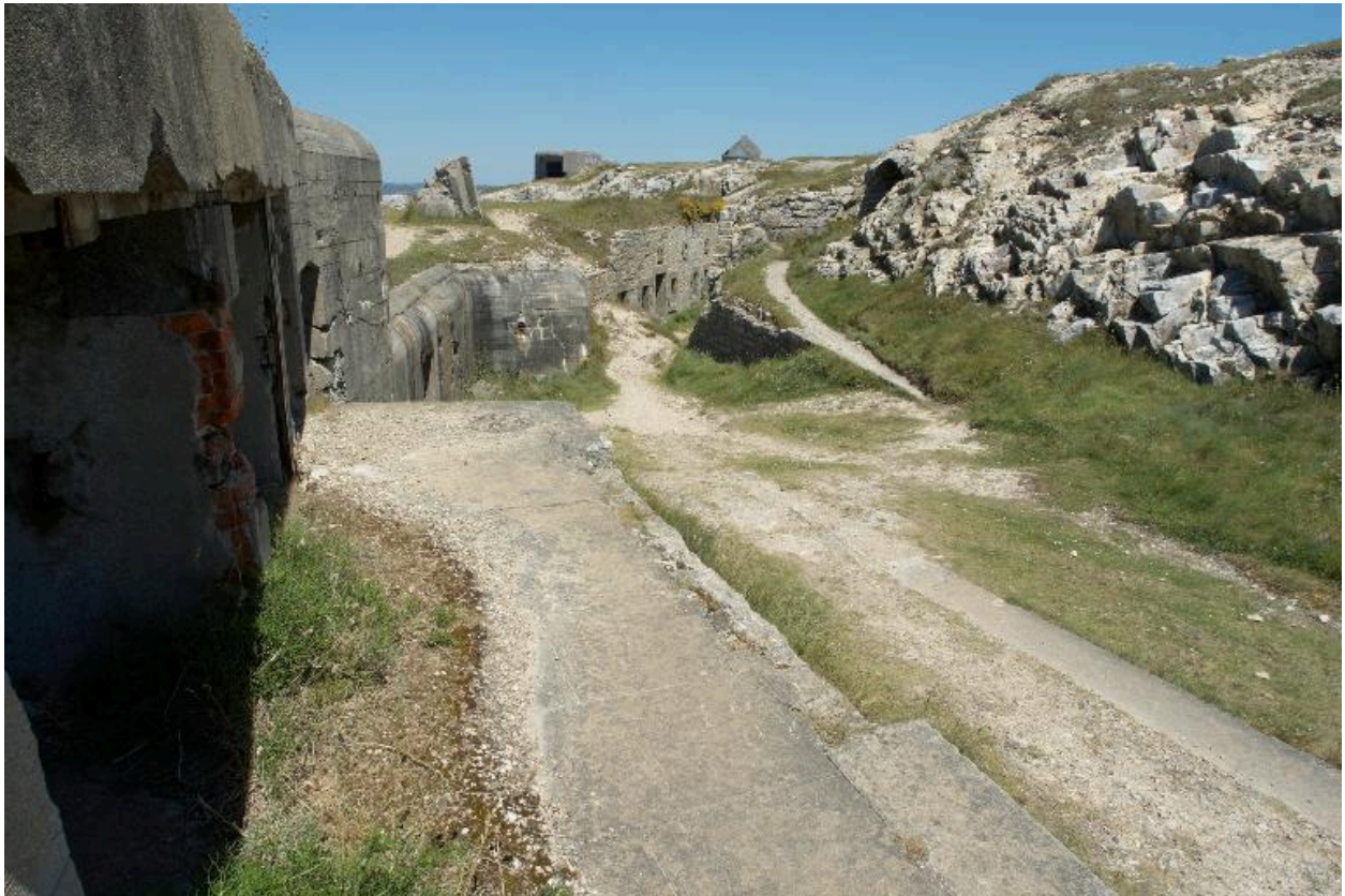
Vue de l'extrémité nord de la batterie de mortier avec le bunker - poste de direction de tir de type M162a. En arrière-plan, l'un des bunkers - casemates pour canon de 164,7 mm
